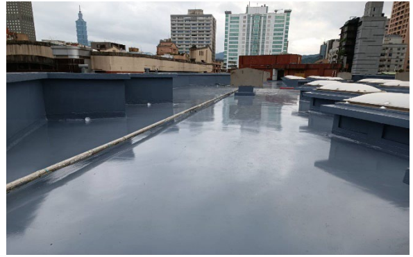
圖 1.5-16 學生第二宿舍頂樓防漏工程完成結果
