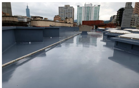
圖 1.5-12 第二宿舍頂樓防漏工程完工圖
